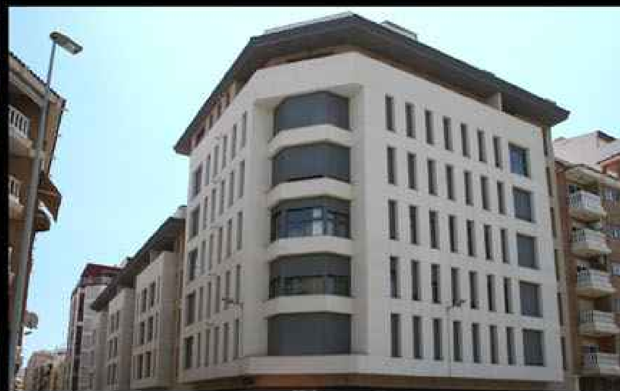
promociones comercializadas. Edificio Xaloc (54 viviendas. 2005-2007) Castellón.
