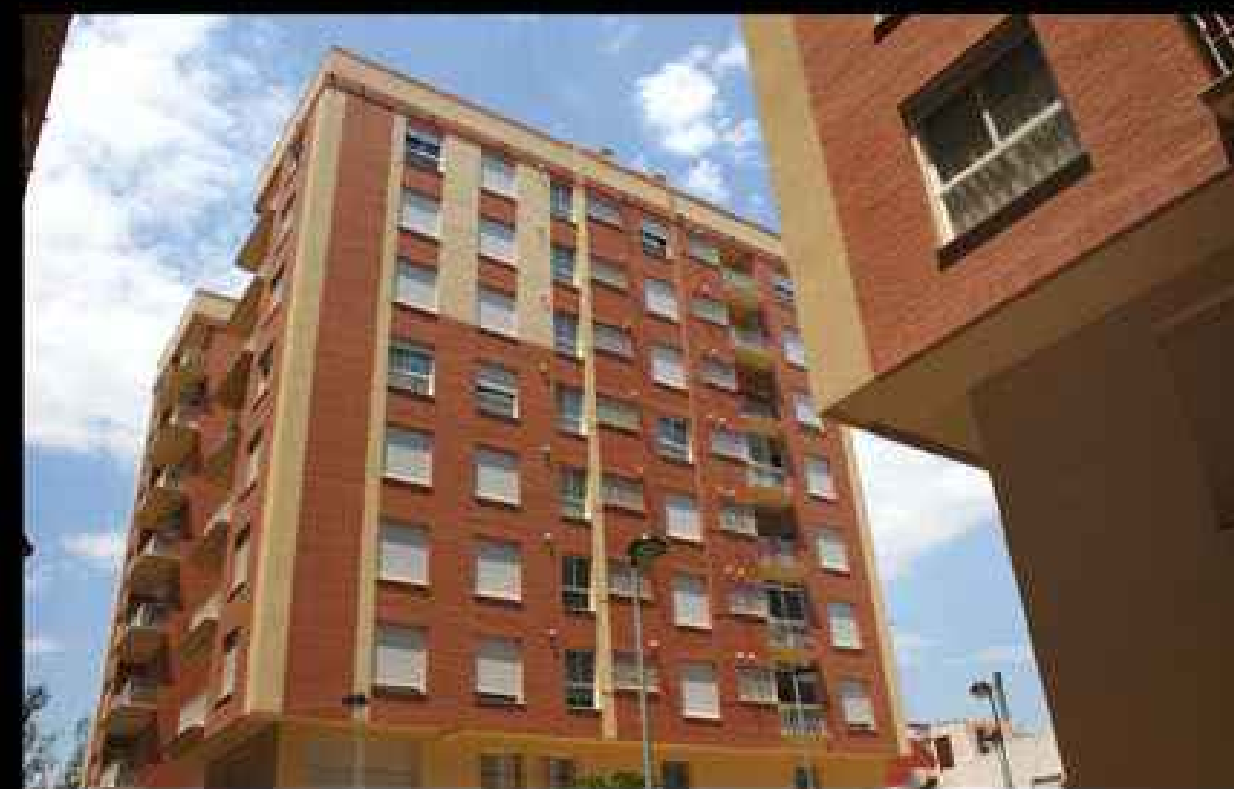
promociones comercializadas. Edificio Skorpis (70 viviendas. 2002-2004) Castellón.
