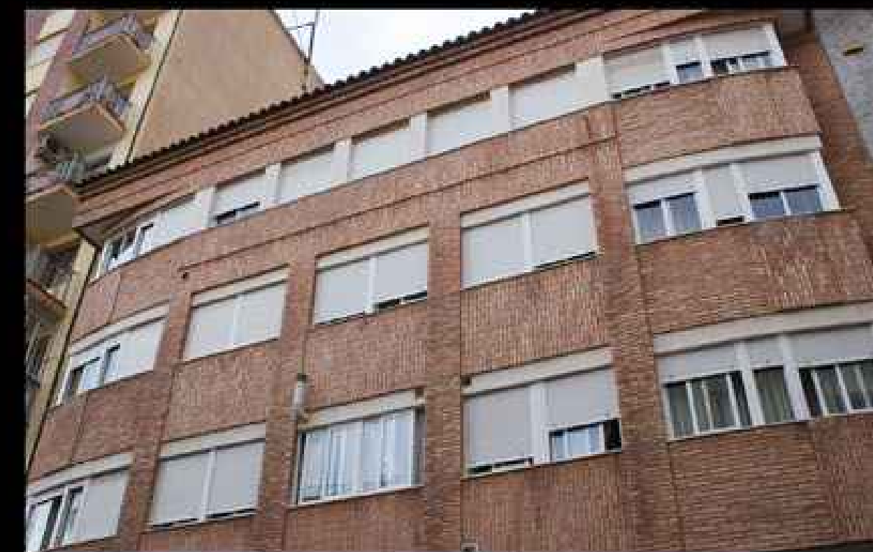
promociones comercializadas. Edificio Marqués de Valverde (12 viviendas. 1995-1997) Castellón.
